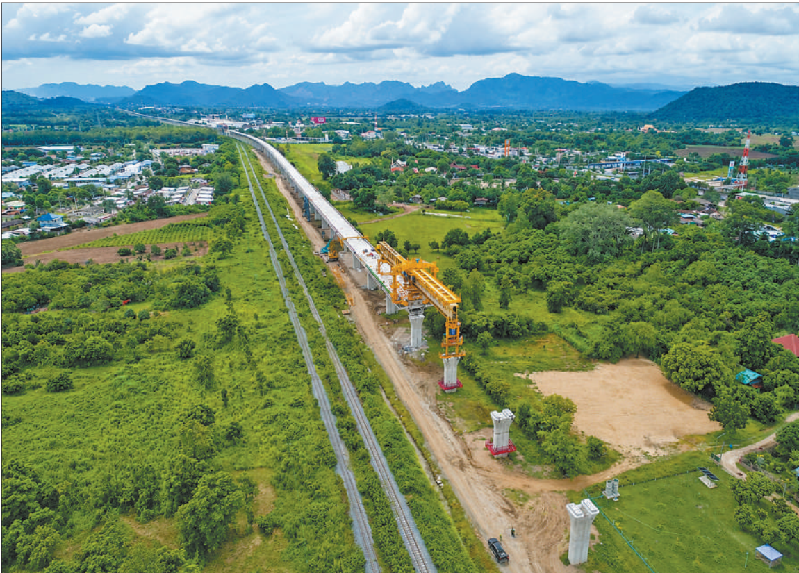
中泰铁路是两国高质量共建“一带一路”的旗舰项目,也是泰国首条采用中国标准设计建设的高速铁路。图为近日,在沙拉武里府中泰铁路C3—1标段英莱特大桥施工现场,中铁十局建设者们抢抓施工有利时机,全力保障项目建设进度。 李建言摄
